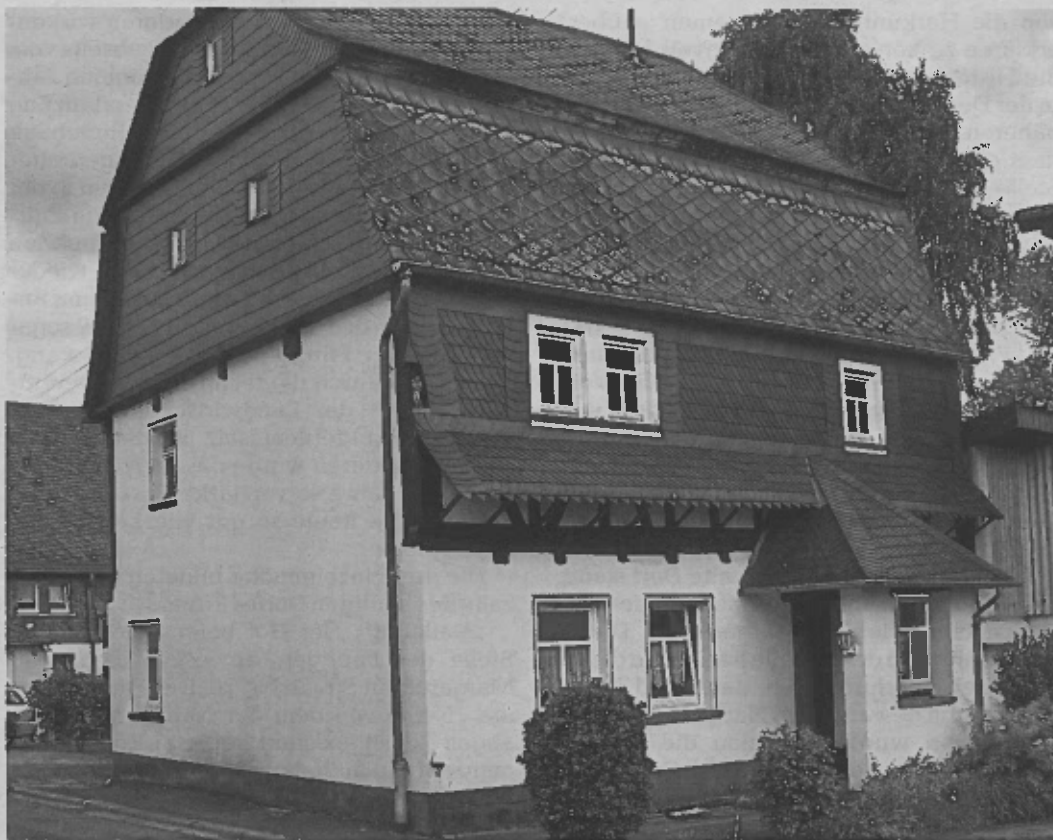
Das alte Gebäude des früheren Sosberger Vogtes wurde von den Nachkommen liebevoll und stilgerecht restauriert. Es ist immer noch eine echte Augenweide im Ortsbild der Hunsrückgemeinde. Foto: Richard Theisen
